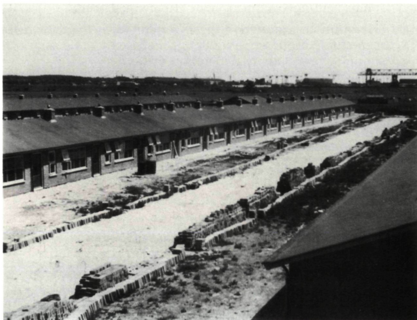
De 410 semipermanente woningen in de Babberspolder in aanbouw
