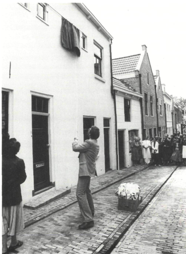
9. Renovatie Schoolstraat voltooid. 1981. 22 juni 1981.
