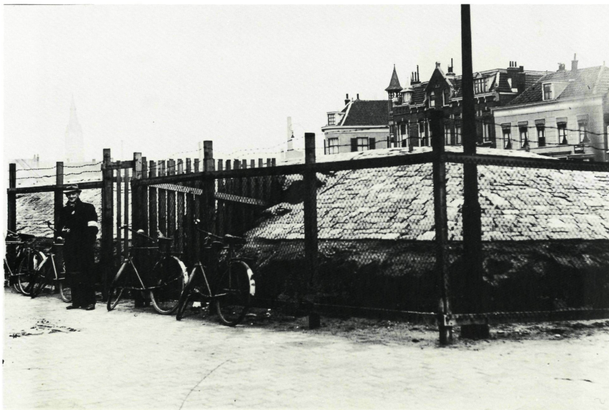
Openbare schuilkelder Westhavenplaats-Westhavenkade. Ca 1942.
