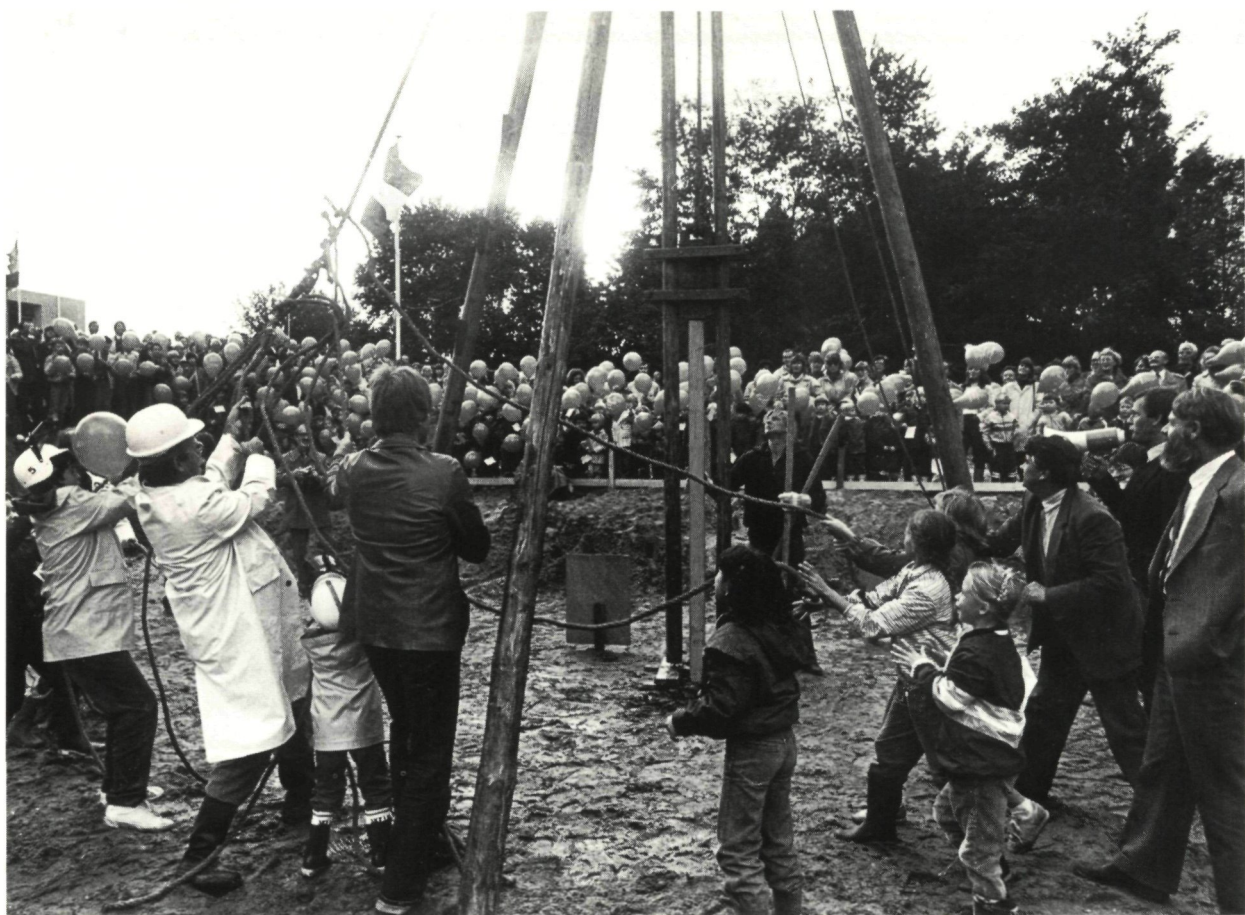
De eerste paal van de nieuwe Jan Ligthartschool, 2 oktober 1984.
