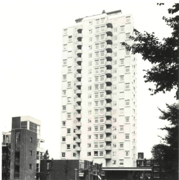
De Bolder, ouderenwoningen Westhavenkade. 3 november 1984.
