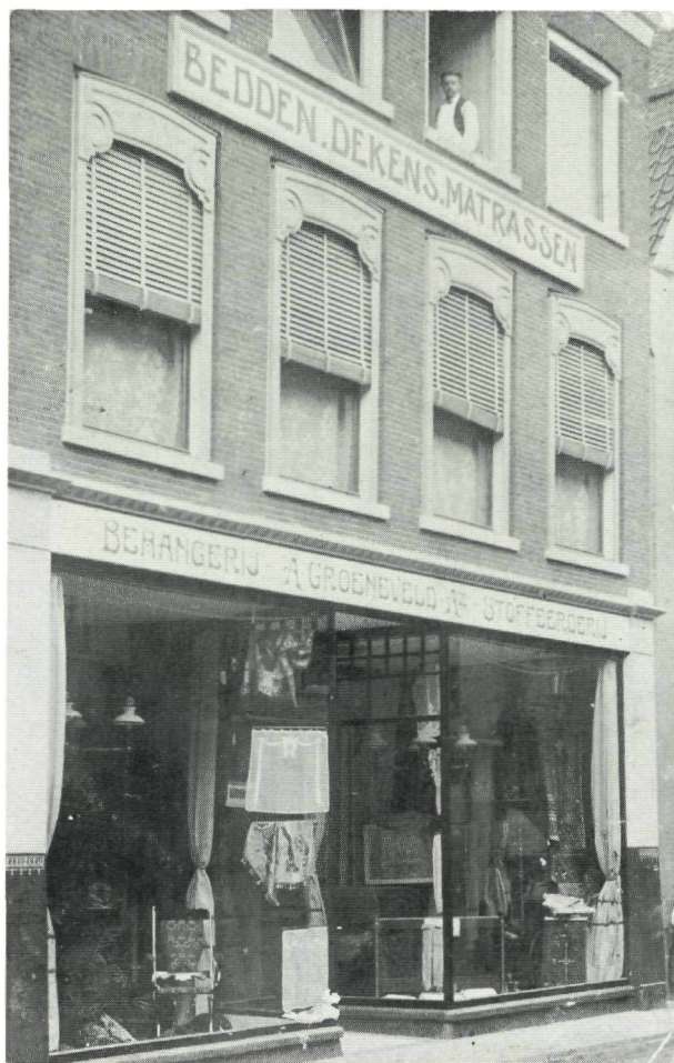
Pand Hoogstraat 205 voor de verbouwing. 24 november 1938.
