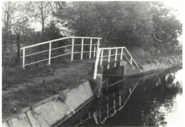
Brug met ongelijke leuning in het trekpad langs de Noordvliet nabij de Vlaardingse Schouw. De leuning vormde geen obstakel voor de lijn van de trekschuit.
