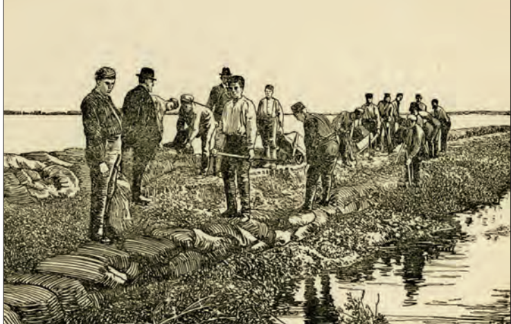
Werkzaamheden aan de Harreweg, na de tweede doorbraak van de kade van de Noord-Kethelpolder in 1903. Tekening uit "De geschiedenis van een polder in het Hoogheemraadschap van Delfland". Vlaardingen 1920.
