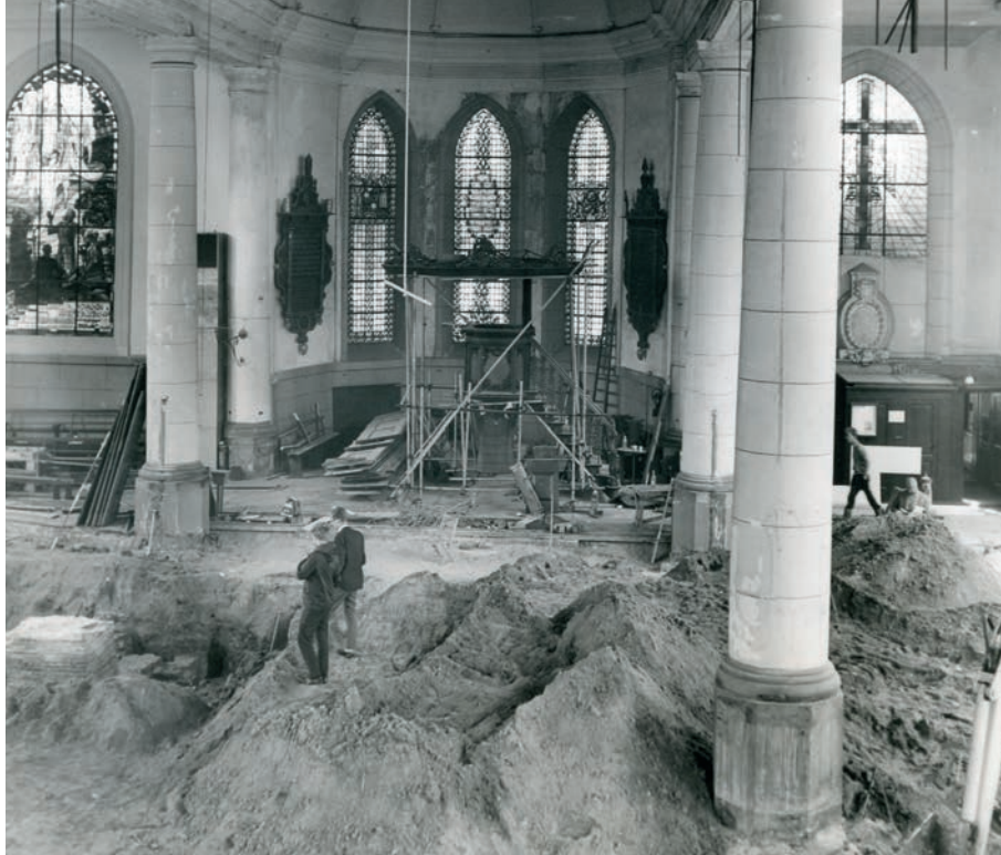
Werkzaamheden in de Grote Kerk (7 juli).
