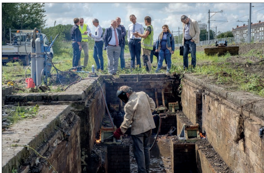
Uitgraven spoorweegbrug (31 augustus). (Foto Roel Dijkstra).
