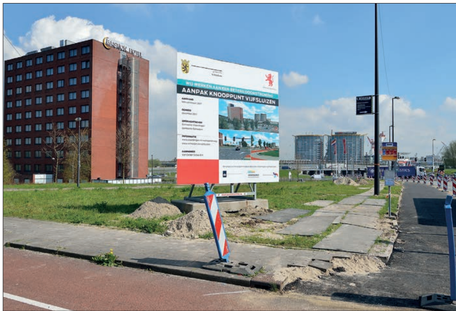
Ombouw plein Vijfsluizen (15 april). (Foto Ron van Rossum).
