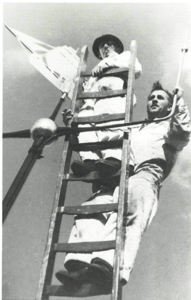
M. de Ridder en L. Droppert plaatsen windwijzer. 12 mei voor tewerkstelling aan de kerkbouw aldaar, worden per advertentie opgeroepen zich aan te melden. Het betreft grondwerkers, betonwerkers, timmerlieden en metselaars. Grondwerkers worden gevraagd zich direct bij architect J. Snijders te melden.
