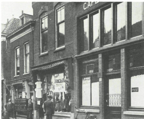
Afbraakprijzen! De sloop van deze panden maakte de doorbraak compleet, 14 november.
