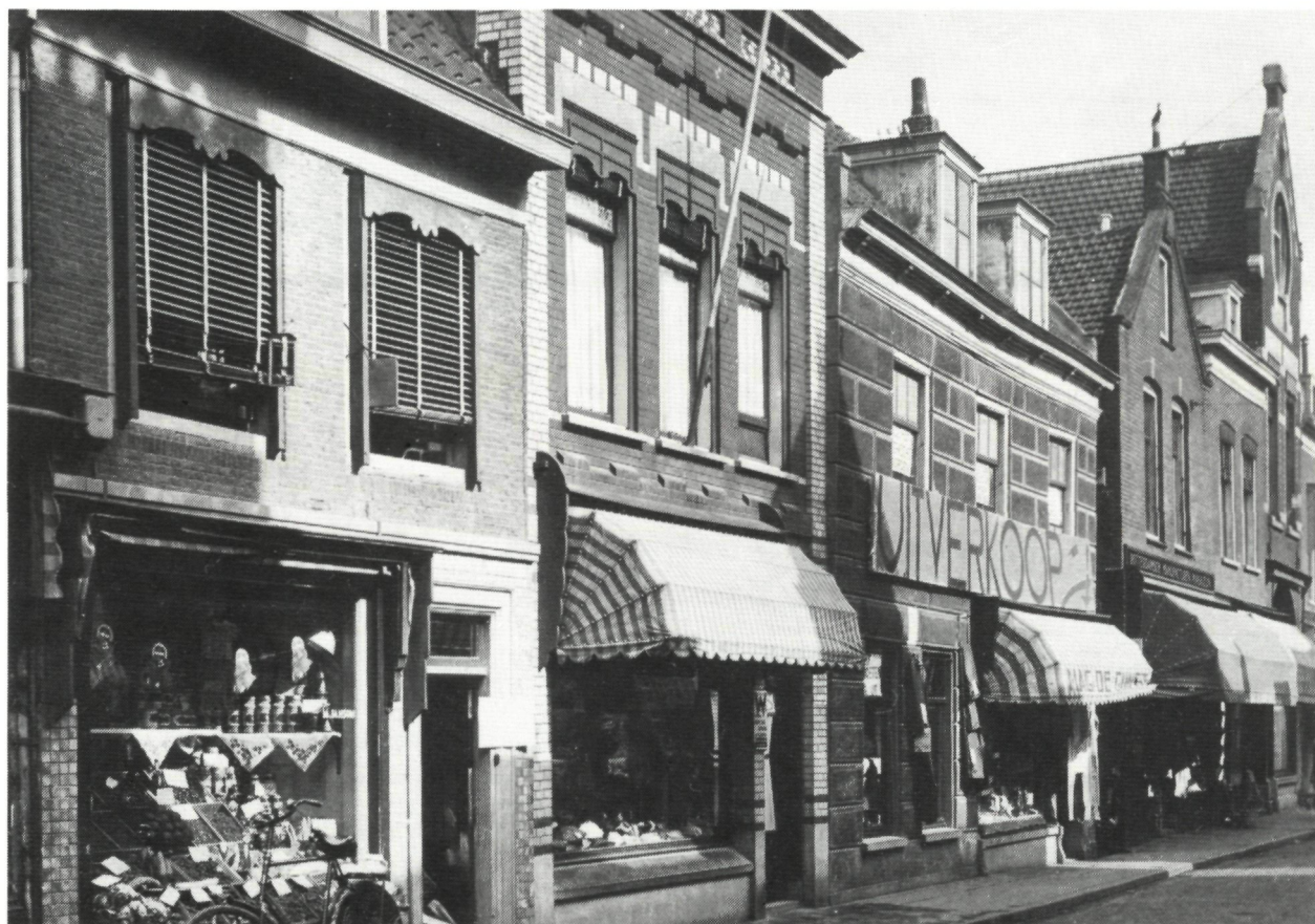
Drie winkelpanden aan de Hoogstraat die gesloopt werden om de latere Korte Hoogstraat mogelijk te maken, 14 november.
