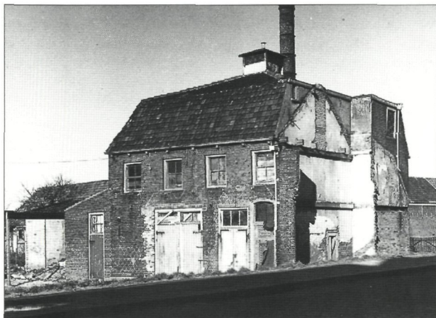
De restanten van de Stoomwasserij aan het Delftseveer. Ter plaatse staat nu het politiebureau aan de Delftseveerweg (12 mei).
