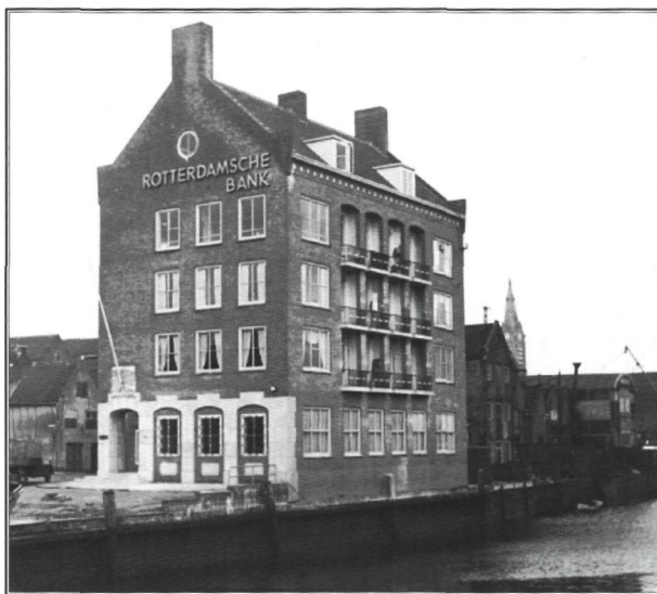
De vestiging van de Rotterdamsche Bank aan de Westhavenplaats 40-43. Volgens ontwerp van ir. E.H. Kraaijvanger c.i. en H.M. Kraaijvanger, architect, gebouwd in de late Delfse-School stijl, met een onderpui van kunst-graniet, waarboven de gemeentewapens van Rotterdam en Vlaardingen (15 november).
