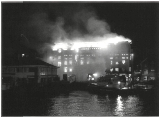
Een impressie van de uitslaande brand, die het monumentale pakhuis aan de Koningin Wilhelminahaven grotendeels verwoest (20 december).
