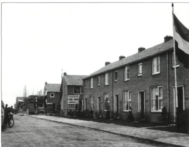
Nieuwe woningen aan de Soendalaan (19 november) (CSV)
