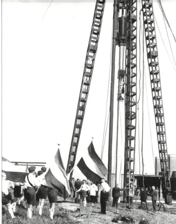
Onder feestelijk vlagvertoon wordt de eerste paal geslagen voor het Cincinnati-gebouw aan de Schiedamsedijk (7 mei). (Collectie J. Borsboom).
