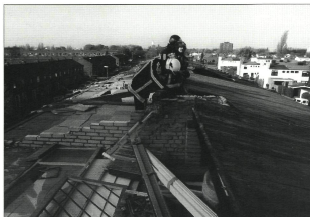
Tijdens een zeer zware storm waait aan de Billitonlaan het dak van een rij woonhuizen (27 oktober). (Foto Roel Dijkstra).
