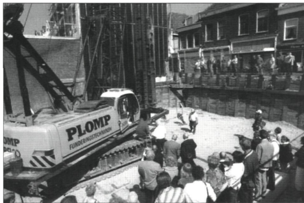
De eerste paal wordt geslagen voor het nieuwbouwproject De Vlijt op de hoek van de Hoogstraat en de Korte Hoogstraat (23 april).
