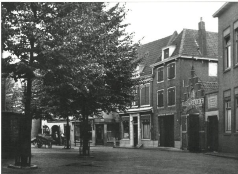
Hier stond ooit het Heiligegeest Gast- en Weeshuis en later een stadsboerderij. In 1913 werden hier kantoor en werkplaatsen voor gemeentewerken gebouwd, waaraan de gevelsteen nog herinnert.
