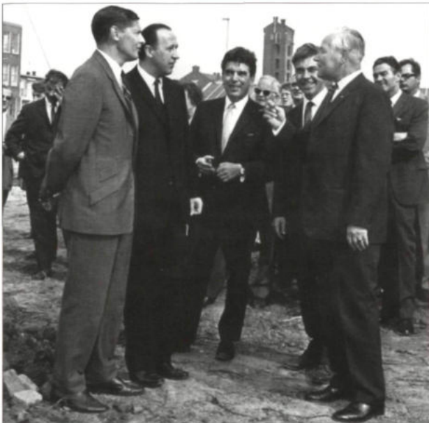
De heren praten na over het slaan van de eerste paal voor het nieuwe kantoorgebouw, 9 september 1968. Van l. naar r.: directielid Aannemingsbedrijf v/h Fa. Schroot & Co., ir. J.G. Gerritze, architect Van Tussenbroek, ir. G.B. Meijer en burgemeester Heusdens. (Foto H.M.C. van den Berg, coll. Stadsarchief).
