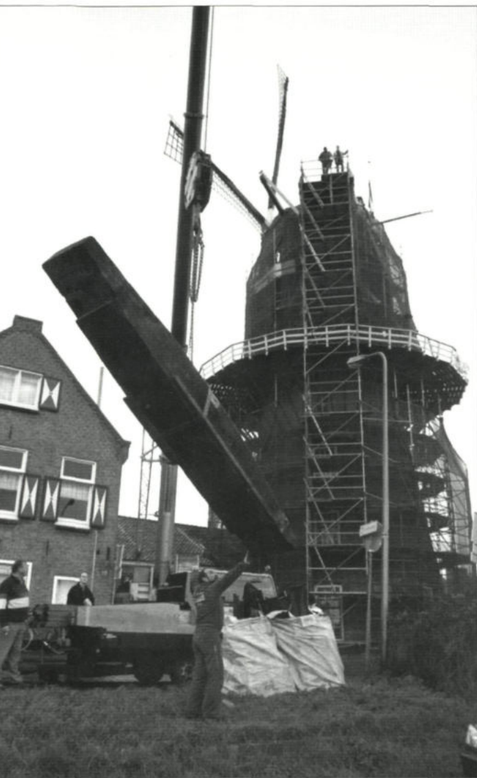
Een loodzware penbalk wordt door een hijskraan in de nok van molen Aeolus aan de Kortedijk getild (3 december). (Foto Roel Dijkstra).
