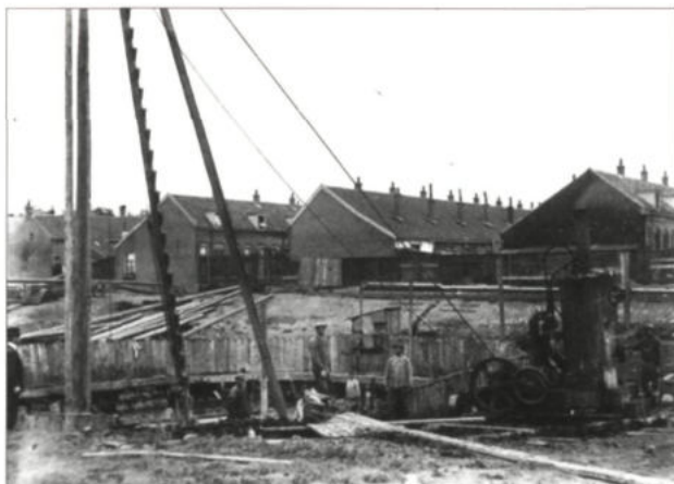
In 1921 wordt nabij de Markgraafaan een gewapend beton kelder met paalfundering voor een rioleringsgemaal aangelegd. Op de achtergrond een aantal inmiddels verdwenen straten, waaronder de Ruytenburchstraat. (Coll. Stadsarchief)
