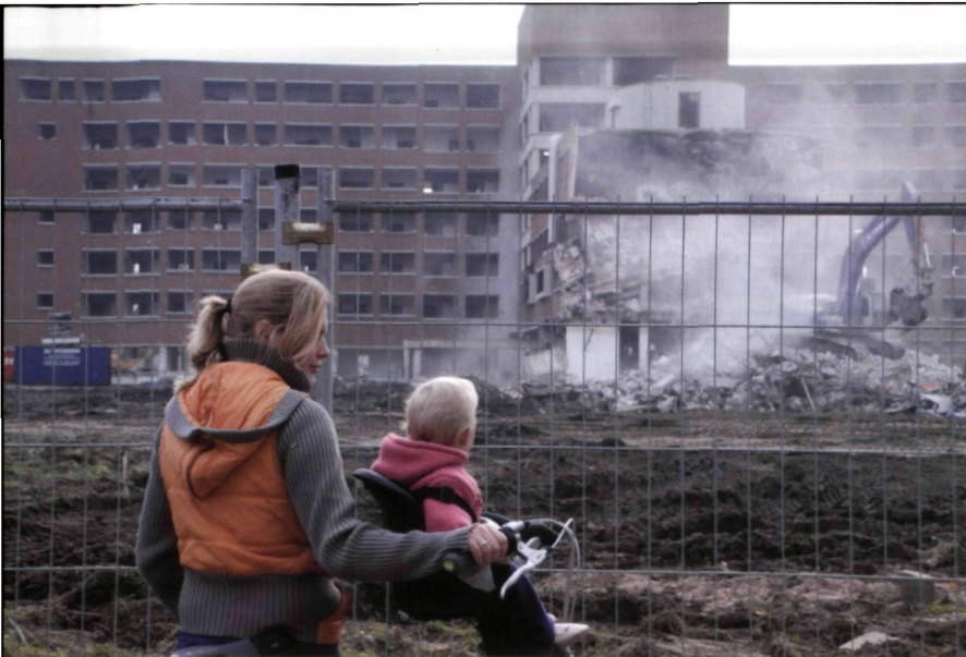
Voormalige Holy Ziekenhuis valt ten prooi aan slopershamer (28 september).
