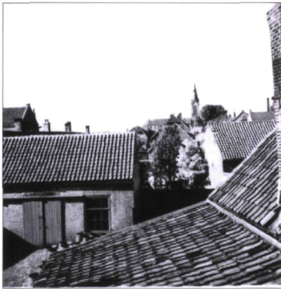
De nieuwe loods met op de achtergrond de toren van de r.k. kerk aan de Hoogstraat. (Collectie L. van der Lely-Kornaat)
