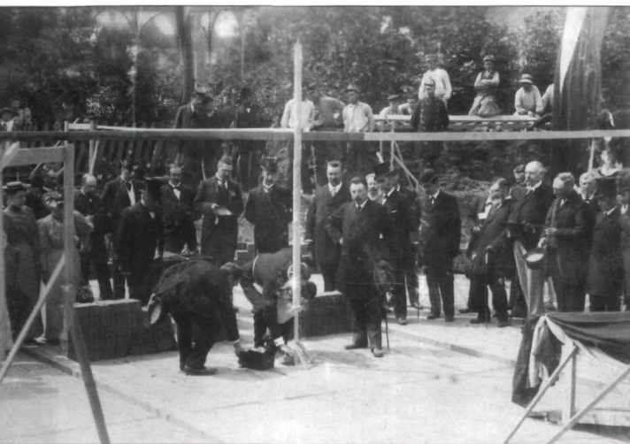
De eerste steenlegging door burgemeester van Vlaardingen R.P. Verploegh Chassé.
