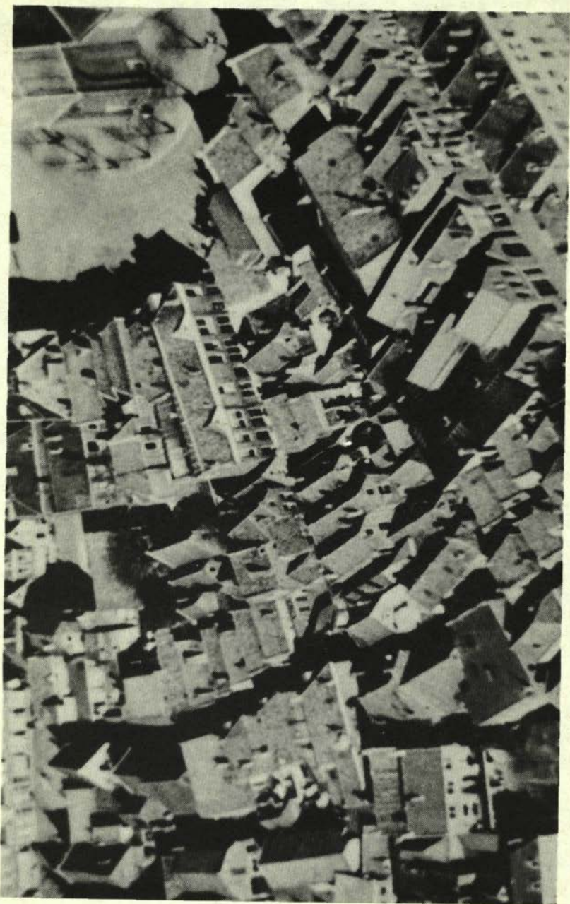
DETAIL VAN EEN LUCHTFOTO UIT 1938. Rechts de voet van de kerktoren. In het midden de school aan de noordzijde en de achtergevels van de huizen aan de zuidzijde van de Schoolstraat.
