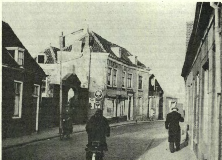
De voormalige en inmiddels gesloopte R.K.pastorie aan het Emaus. Achter dit gebouw lag het oude kerkje.
