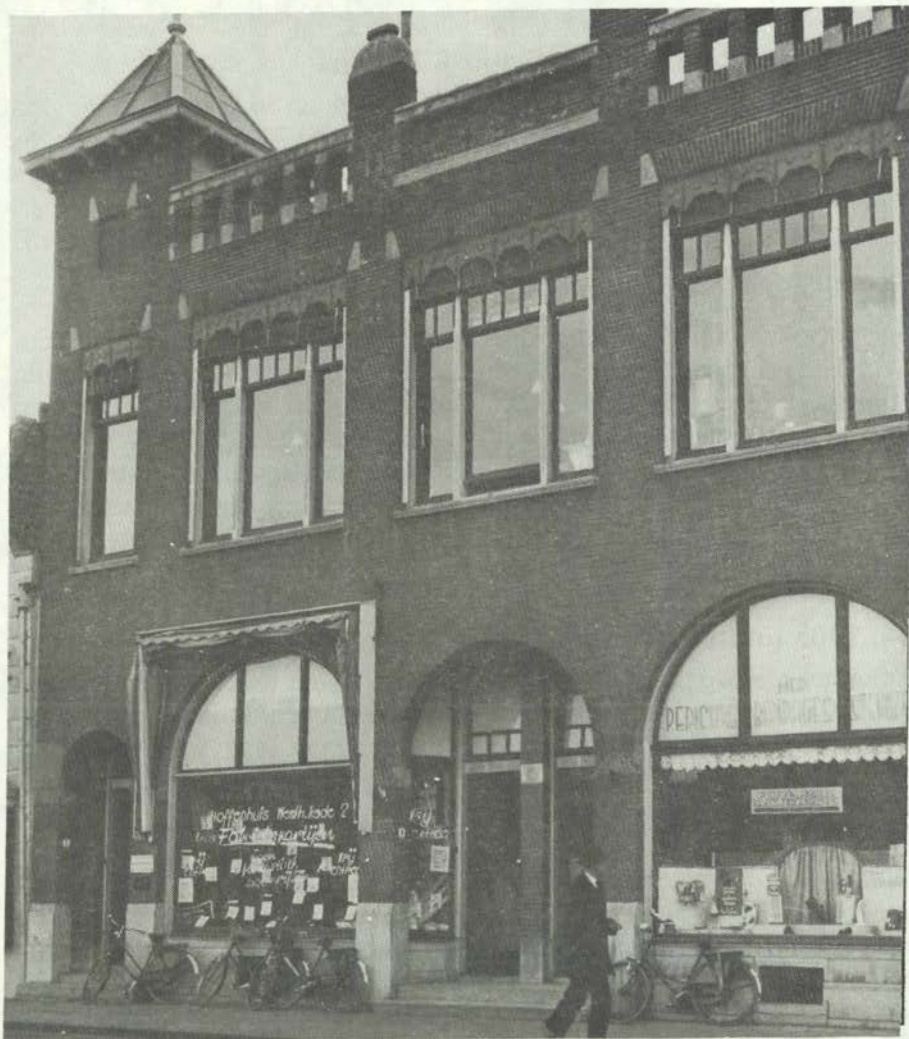
Het uit 1906 daterende pand herbergde diverse winkels. Op deze foto van 1954 links Van Moorsel Stoffen en rechts de firma Vermeulen met orthopedische maatschoenen en pedicure.
