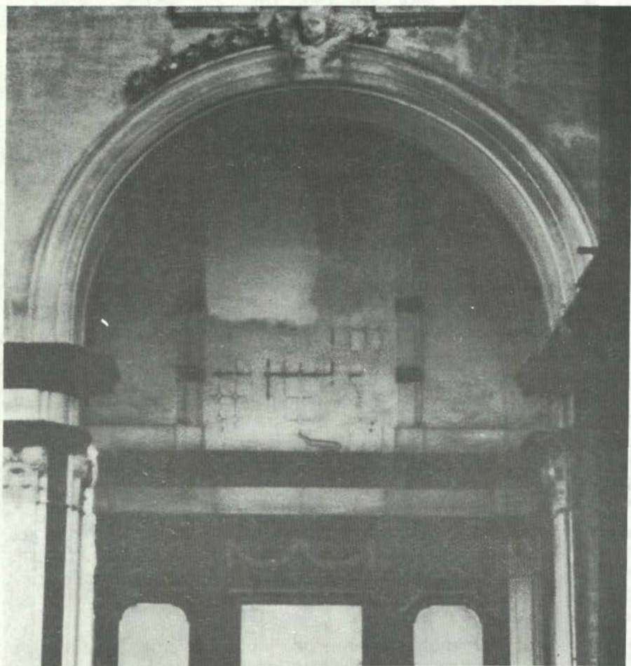
Een kijkje in de zijbeuk van de kapel van de Baudeloo-abdij. Let op de nog aanwezige ornamentiek. Deze vertoont grote overeenkomst met het snijwerk aan het oxaal dat nu in Vlaardingen staat (Foto Adri Hoogendijk).
