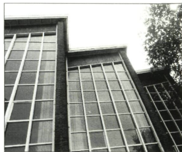
De Pniëlkerk verdween, ondanks protesten van de HVV, in 1999 onder de slopershamer. (Foto: A.J. van Bommel)
