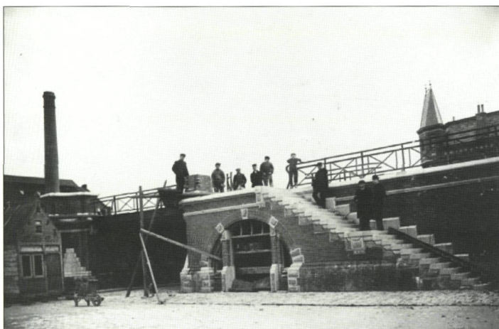
De bouw van de 'tunnel', het viaduct aan het eind van de Binnensingel over de spoorlijn naar de Koningin Wilhelminahaven, in 1903. (Foto: Stadsarchief Vlaardingen)
