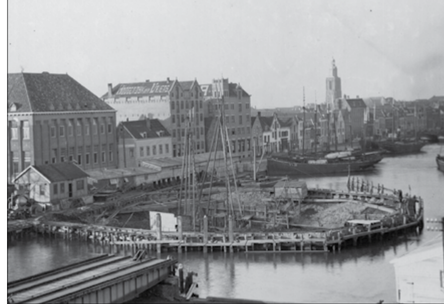
Het heiwerk voor de fundatie van de bouw van de 2e keersluis en de Prinses Julianabrug is in volle gang. Links het pas gebouwde Handelsgebouw en op de achtergrond de stalen sloep VL 31 'Francisca' van rederij G. Vriens, 1920. (Collectie Stadsarchief Vlaardingen).
