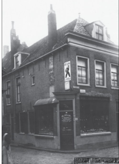
Hoek Landstraat/Zomerstraat. De ‘hoogevloed-steen’ zit links naast de deur. (Foto: Stadsarchief Vlaardingen)
