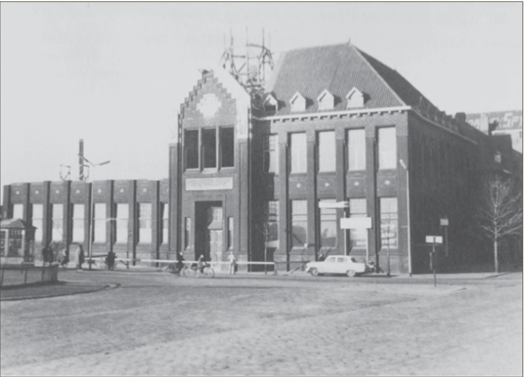
De sloop van het Handelsgebouw. Foto: J. Sluimer
