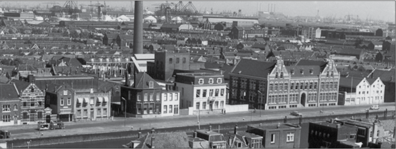
Hoog torent de schoorsteen boven de Oostwijk uit.
