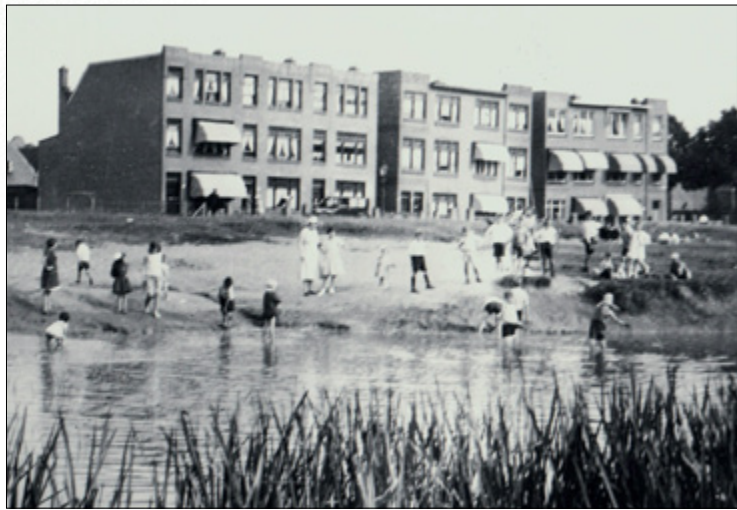
Al kort na de bouw verzakten de woningen aan de Julianasingel die waren gebouwd op het oude Spuiwater.
