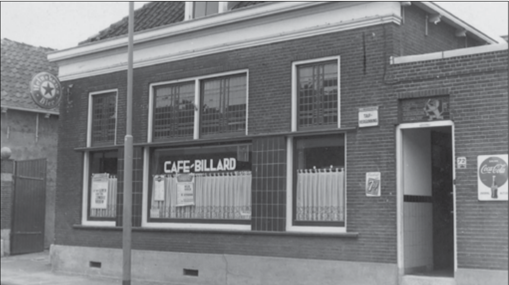
Café A.J. Waardenburg, Emous 72, waar in 1936 een brandalarminstallatie werd ondergebracht. (Foto: Stadsarchief Vlaardingen).
