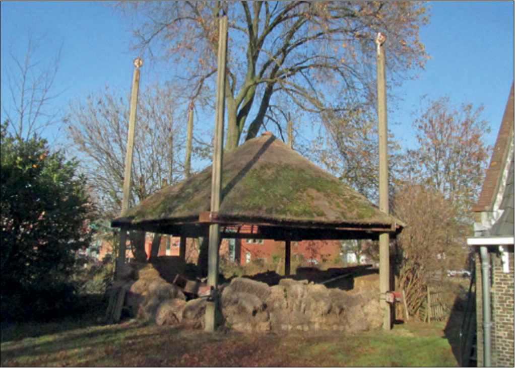
De houten roeden van de hooiberg achter de stal van Hoogstad zijn vervangen door betonnen roeden. De andere hooiberg heeft ingekorte houten roeden.
