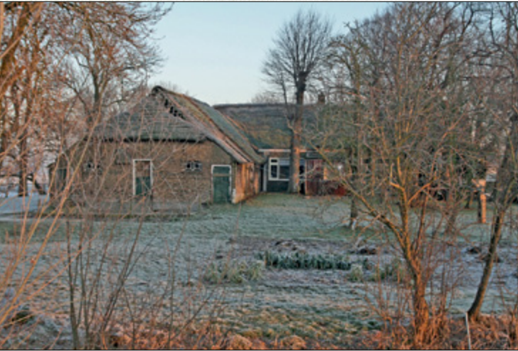
In boerderij Trek- kade 24 aanwezige 19e-eeuwse schilde- ring van de boerderij (Bron: bouwhistorisch onderzoek door Frits van Ooststroom) (Foto Frits van Ooststroom)
