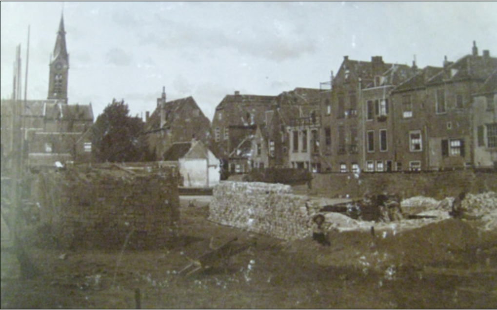
Bouwterrein aan de Achterstraat. Rechts: achterzijde van de hui- zen aan de Hoogstraat, 1912. (Collectie Stadsarchief Vlaardingen)
