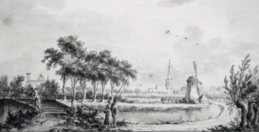
De Schout Jansbrug bij Schipluiden. De latten op de brug voorkwamen dat het trekpaard zou uitglijden. Tekenaar onbekend, ca. 1750. Particuliere collectie.
