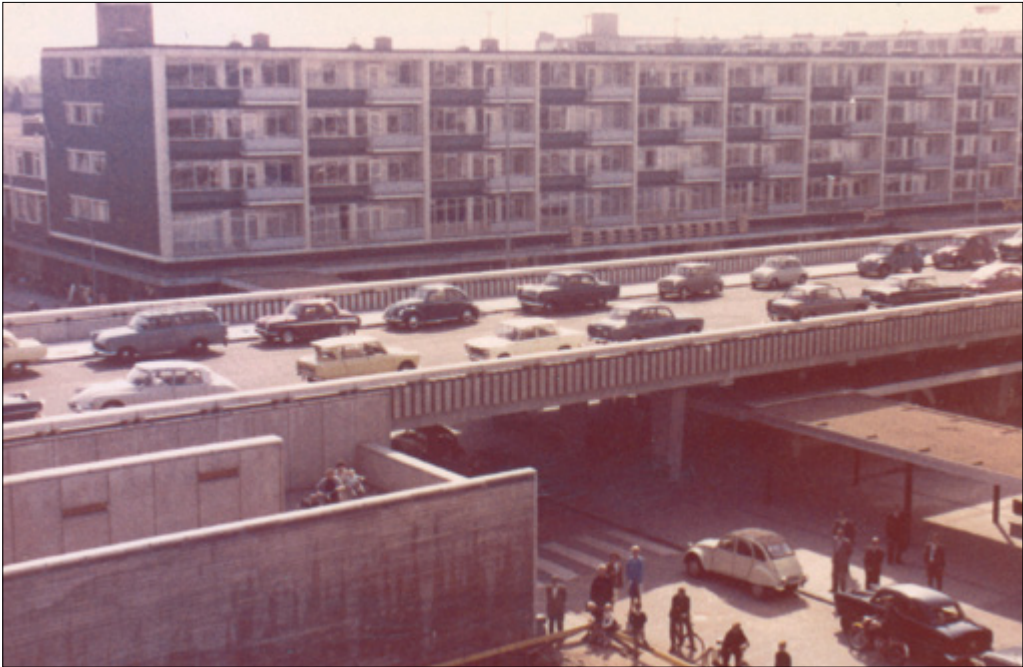
Het nog maar kort gereed gekomen Liesveldviaduct wordt hier nog gebruikt als (gratis!) parkeerplaats. Op de voorgrond een van de beruchte en thans verdwenen voetgangerstunnels. (Foto: J. van der Heul, collectie HVV)
