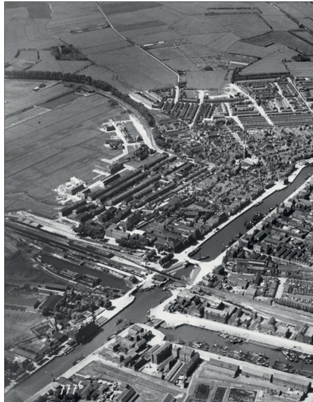
Een luchtfoto uit 1929 van het westelijk deel van de VOP in aanbouw. Er staat al twee blokken van het latere Messchaertplein en daar tegenover twee blokken aan de Diepenbrockstraat. Voor de rest is alles ten westen daarvan weiland met grazende koeien. (Foto: Stadsarchief Vlaardingen)
