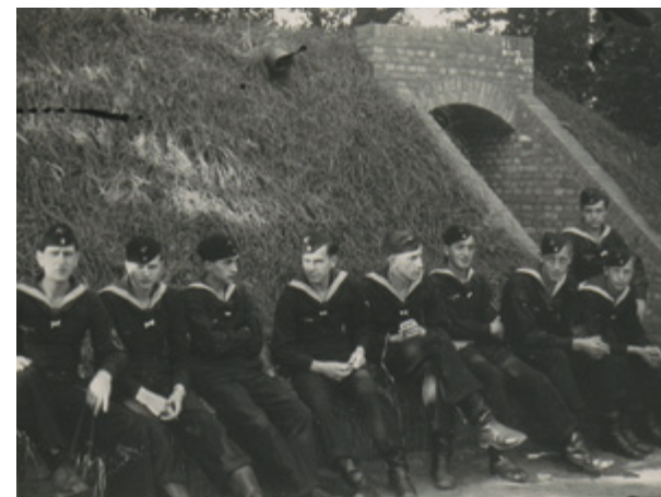
Rustmoment voor een van de schuilkelders. Rechts de gemetselde toegang van de schuilplaats met links daarvan een ontluftpip.
