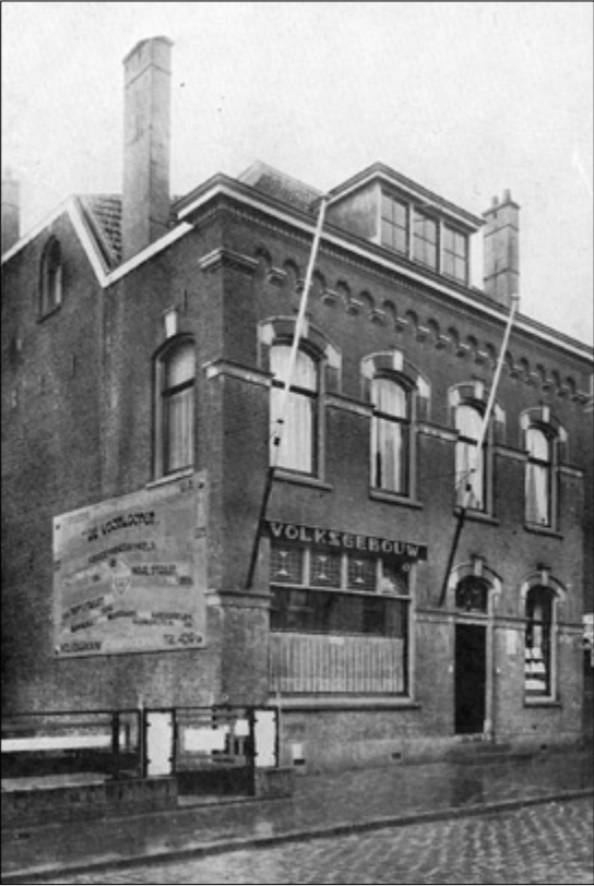
Het Volksgebouw aan de Schiedamsedijk.
