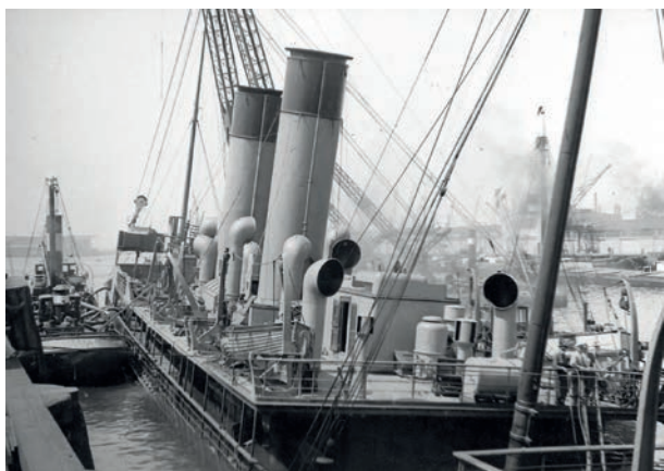
November 1940, bergingsbedrijf Van den Tak uit Maassluis bezig met het lichten van de St. Denis. (collectie Nationaal Sleepvaart Museum Maassluis, archief Van den Tak)
