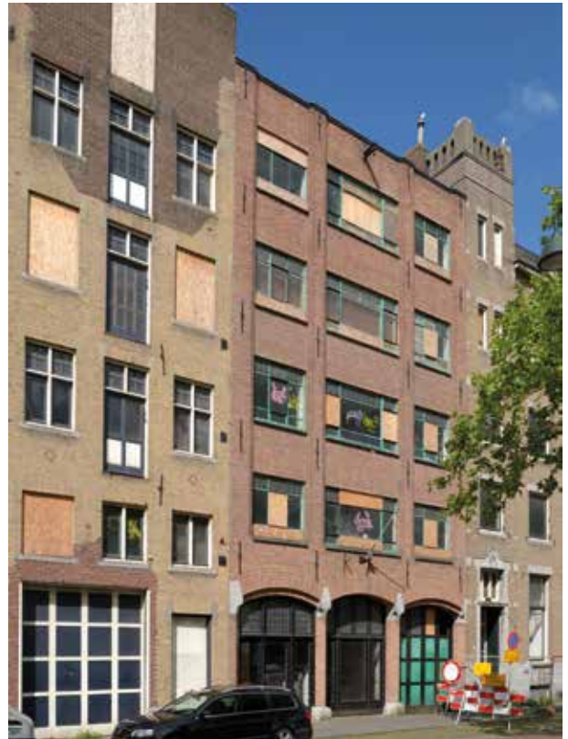
Deel van de gevel van de inmiddels verlaten toonzaal van Sprij aan de Westhavenkade. Foto Frans Assenberg.
