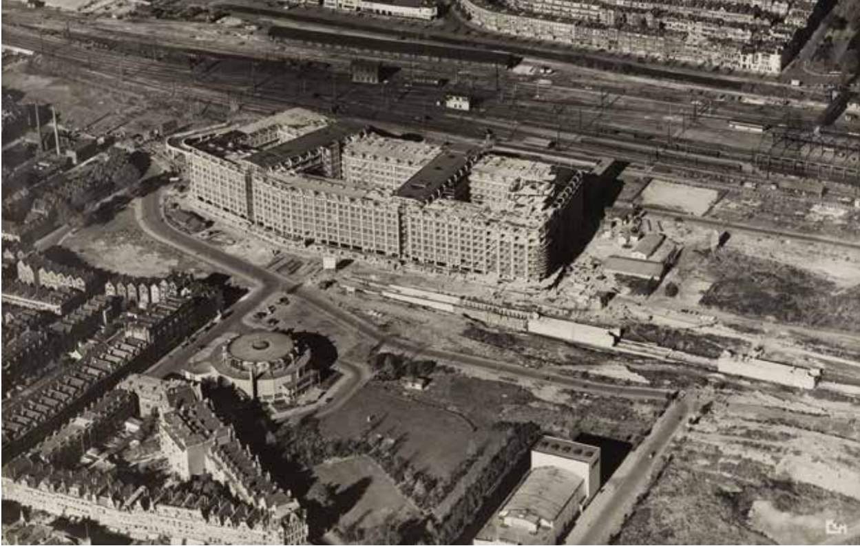
Groothandelsgebouw, Stationsplein 45, Rotterdam (1945-1952). Luchtopname Weena met het gebouw in aanbouw, 1951 (klm Aerocarto).
